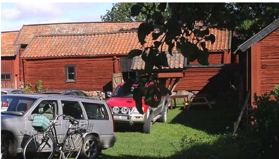
På ladugårdens norra takfall regnar det in.
